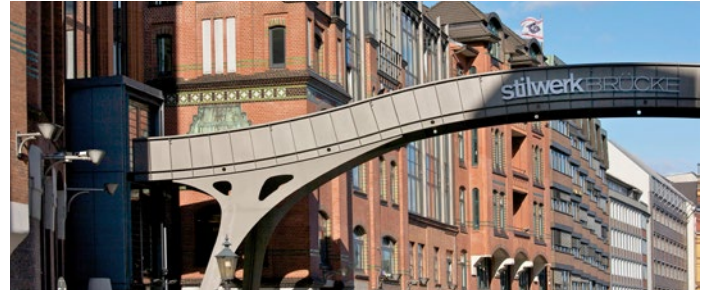
markilux Showroom Hamburg stilwerk, Grosse Elbstrasse 68, 22767 Hamburg
